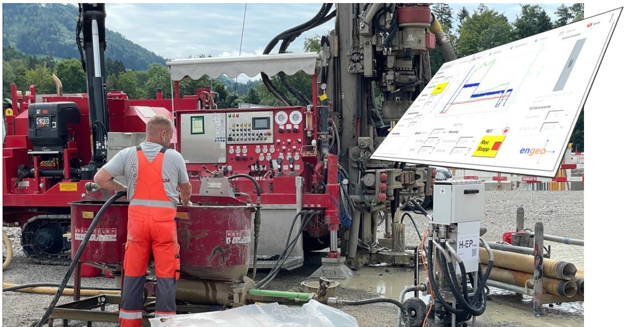
Abb. 3: Bei der Hinterfüllung Anzeige von: zeitlichem Verlauf der Soll- Dichte, Ist-Dichte, des Durchflusses und Einpressdrucks. Zusätzlich wird das eingebrachte Füll-Volumen sowie grafisch der Füllfortschritt angezeigt.
